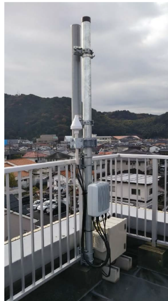
無線基地局(eNB) セクタアンテナ構成
